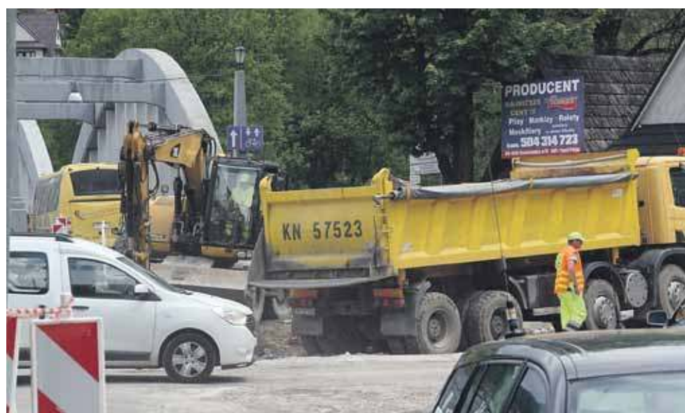
Przebudowa ronda w Krościenku daje się mocno odczuć kierowcom oraz pieszym.
