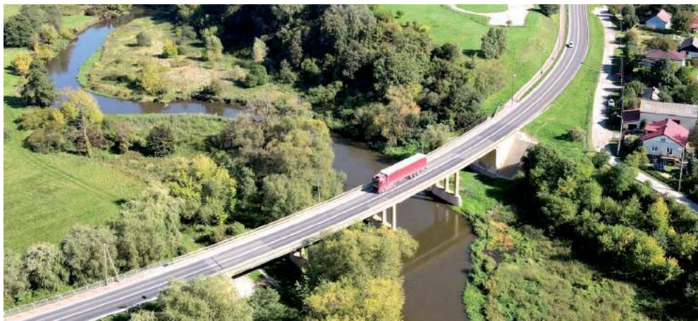
Most w Łęcznej powstał w 1966 roku i jest już w złym stanie technicznym, informując o ogłoszonym przetargu na budowę nowej przeprawy, GDDKiA w Lublinie
