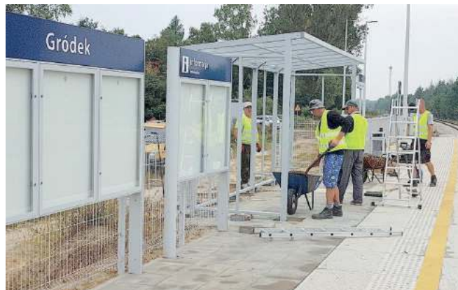
Budowany jest peron na przystanku Parczew Kolejowa oraz peron w Gródku (gm. Siemień). Przygotowano oświetlenie, montowane są ławki, wiaty, ogrodzenie oraz gabloty na rozkład jazdy pociągów
