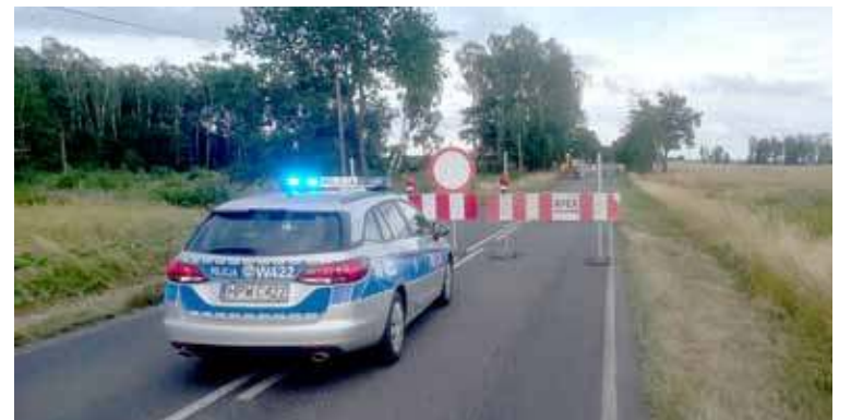
Kierowcy omijali zapory, toteż na jakiś czas musiał tu postać patrol policji. W tle prace budowlane przy przepuszczeniu
