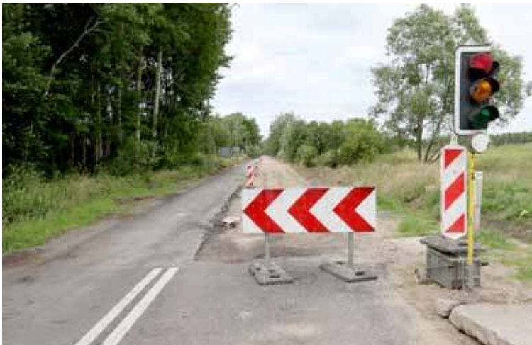
Roboty wymagają wprowadzenia ruchu wahadłowego
