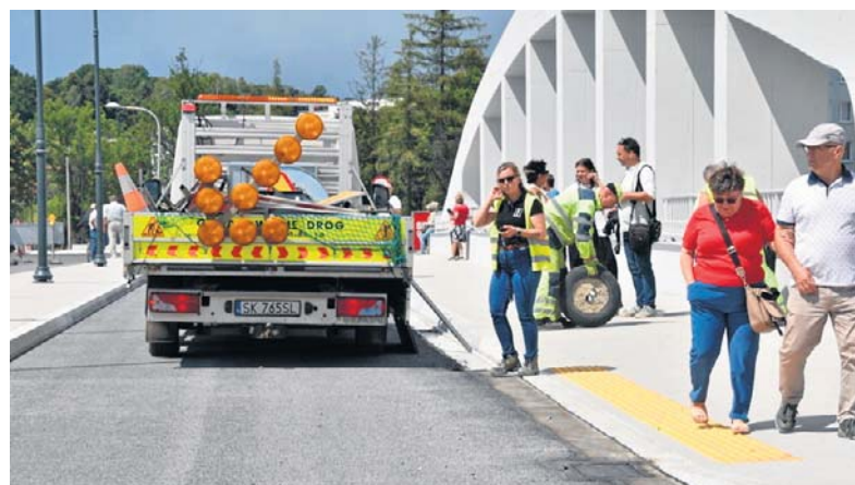
Po oficjalnym oddaniu mostu do użytku mieszkańcy Głucholaz chętnie spacerowali po nowej przeprawie.
