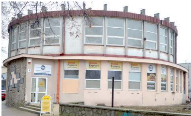
Budynek „Okraglak” został wzniesiony w 1969 r., znajduje się on na ulicy Partyzantów obok kina „Sybilla”. W nim mieścił się m.in. bank czy fotograf. Obecnie trwają tam prace remontowe
