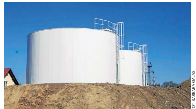
Nowo wybudowane, zapasowe zbiorniki na wodę pitną w Jasionce
