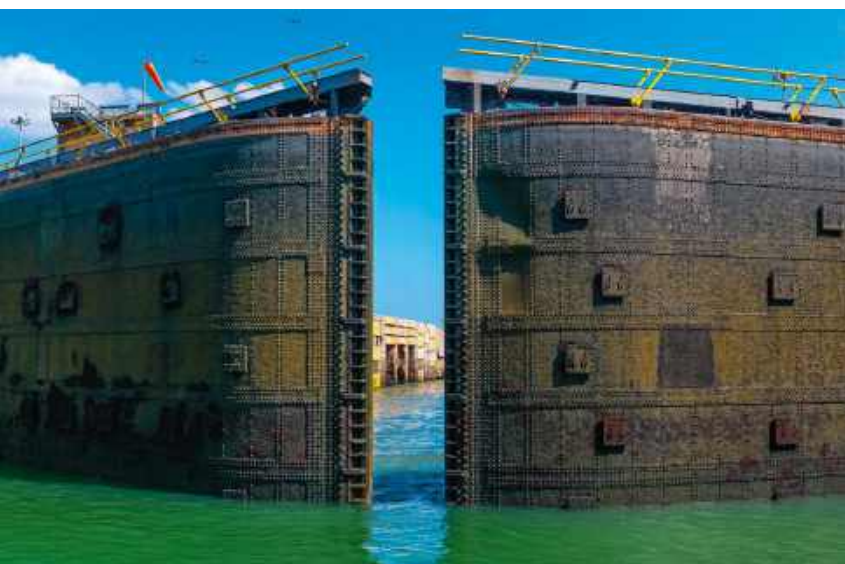
Wrota jednej ze śluz Miraflores, zamykające Kanał Panamski od strony Pacyfiku
