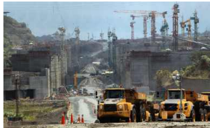
Ogólny widok na prace związane z rozbudową Kanału Panamskiego i zwiększeniem jego przepustowości. Zakończono je w 2016 r.
