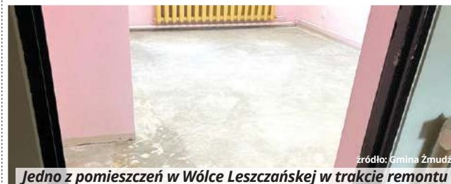
RC Jedno z pomieszczeń w Wólce Leszczańskiej w trakcie remontu
