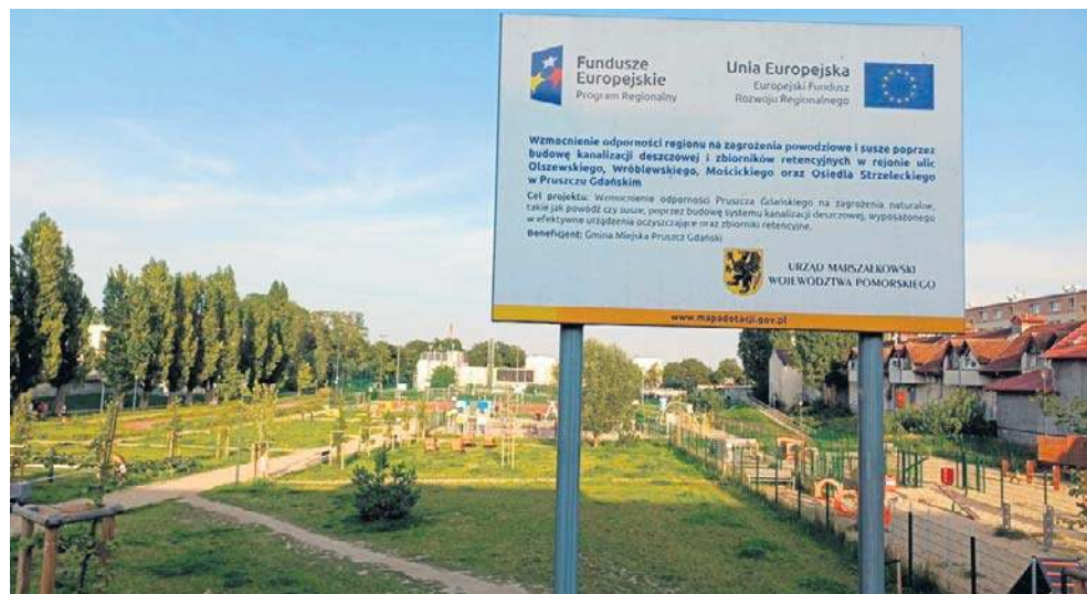
Pod tym ogromnym terenem rekreacyjnym przy ul. Olszewskiego znajduje się jeden ze zbiorników retencyjnych
