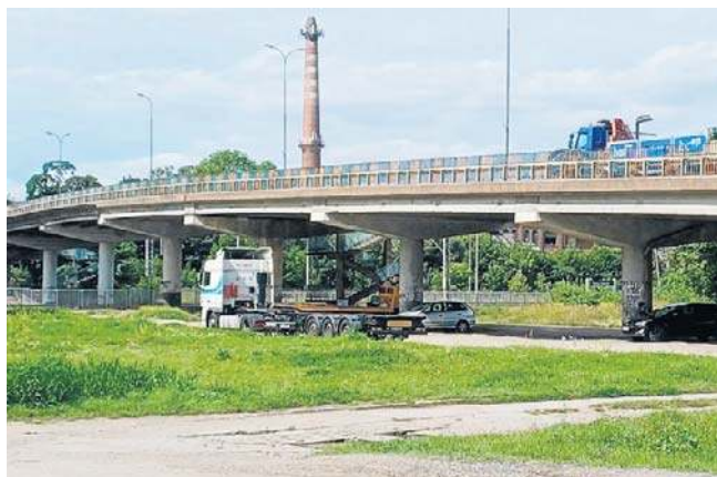
Dotychczasowy wiadukt zostanie wyburzony
