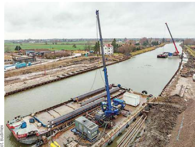
Jednocześnie trwają prace przy realizacji drugiego etapu
