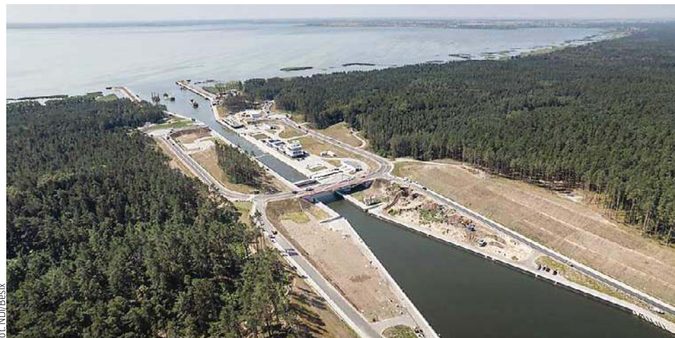
Zakończenie pierwszego etapu inwestycji planowane jest na 17 września
