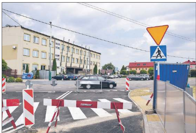
Wyjeżdżający z tunelu będą musieli ustąpić pierwszeństwa przejazdu.
