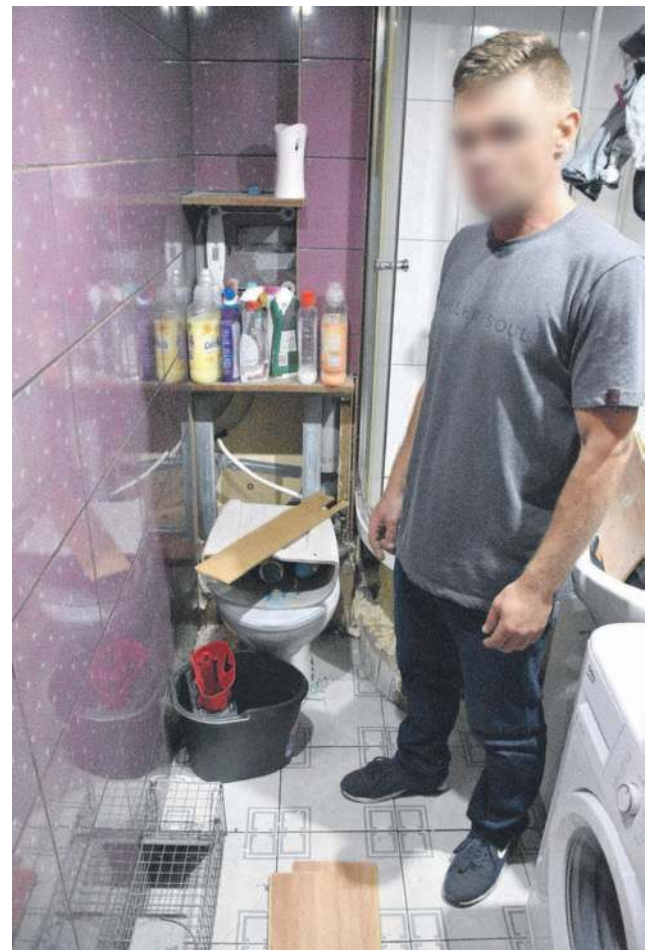
W łazience pana Roberta przeprowadzono odszczurzenie
