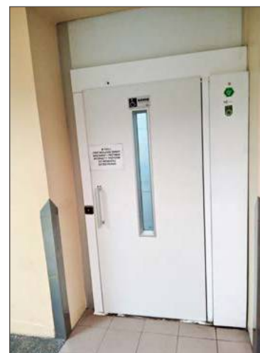
Winda już po remoncie.
