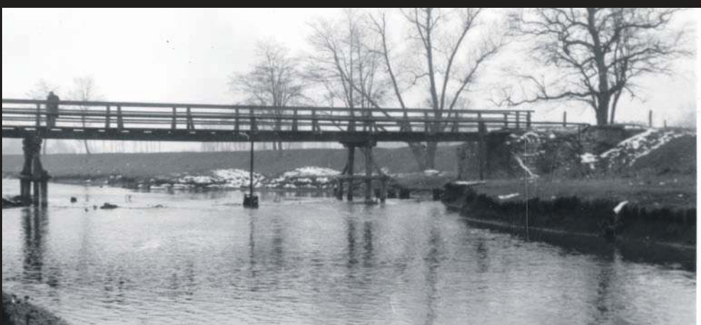
Most na rzece Olawie łączył pl. Zamkowy z ul. Strzelną. Przed wojną był drewniany, ale bardzo mocnej konstrukcji. W czasie wojny zniszczony, po wojnie była kładka, którą woda w czasie powodzi zniszczyła. Obecny most betonowy wybudowano w 1966 roku
