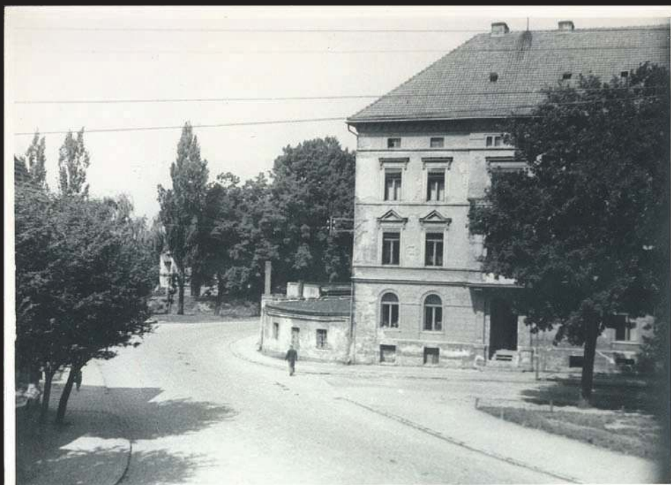
Rok 1949, pl. Zamkowy w kierunku ul. Żymierskiego, po prawej w pawilonach przy budynku był warsztat garncarski Bronisława Nappa
