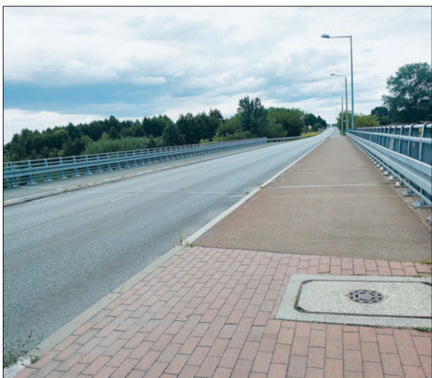
W ramach inwestycji przebudowana zostanie Al. Solidarności i powstanie nowe skrzyżowanie z sygnalizacją świetlną na ul. Sielczyk
