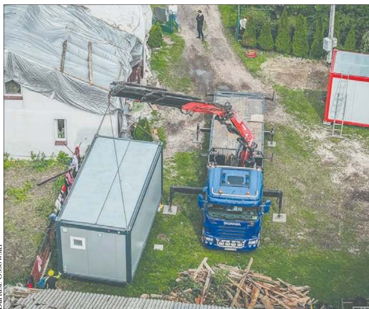
Kontenery przekazane przez firmę Modular System
