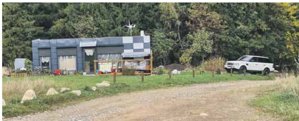
Kontener na Antałówce stoi mimo sądowego wyroku, teren przy blaszaku utwardzono, tworząc miejsce parkingowe.
