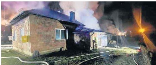
Pali się przylegający do budynku mieszkalnego budynek gospodarczy
