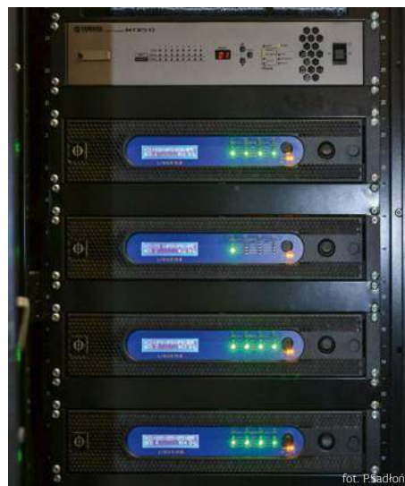
System napędzają cztery wzmacniacze CODA Linus 10-C, do których sygnał dostarczony jest w postaci cyfrowej za pomocą sygnału AES/EBU.
