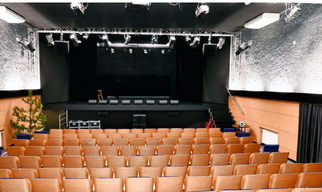
Uwzględniając potrzeby gospodarza obiektu oraz warunki sali widowiskowej system stacjonarny zestawiony został z dwóch podwieszonych zespołów głośnikowych APS na stronę.
