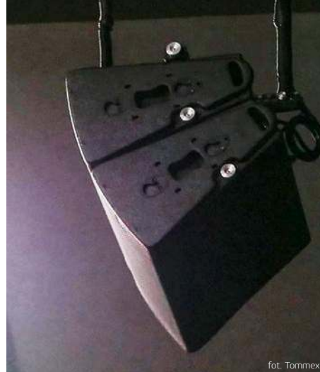
System nagłośnienia sali widowiskowej Bytomskiego Centrum Kultury składa się z czterech zestawów głośnikowych CODA APS (po dwa zestawy stronę).
