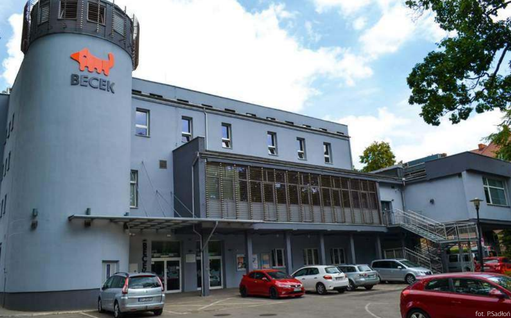
System nagłośnienia CODA Audio w Bytomskim Centrum Kultury został zainstalowany na sali widowiskowej ToTu.
