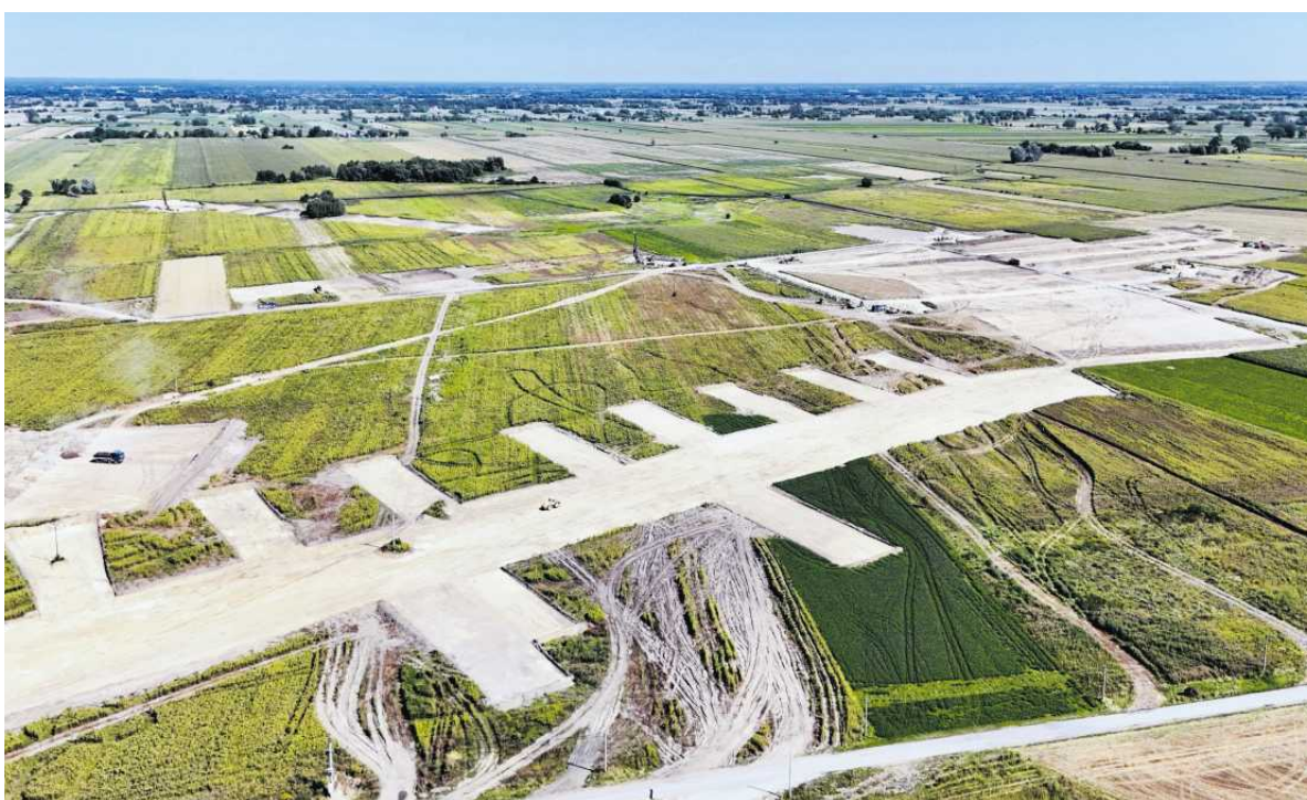
• Prace przygotowawcze na terenie przyszłego lotniska w Baranowie, 14.08.2026 r. FOT. MATEUSZ SKWARCZEK / AGENCJA WYBORCZA.PL
