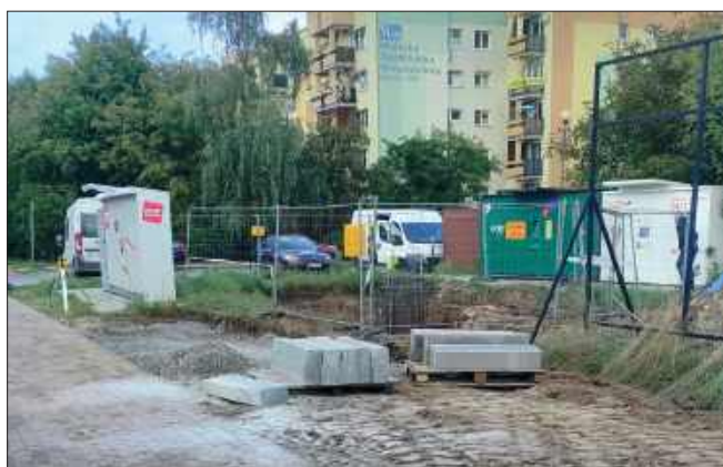
Na Smoczce trwają prace.
