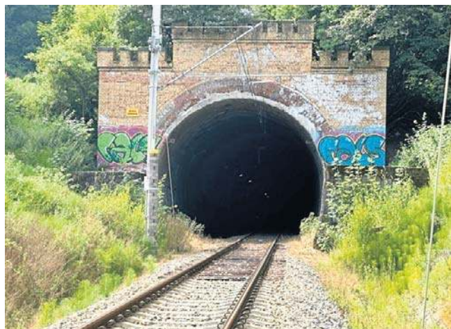
Budowa tunelu rozpoczęła się w połowie XIX wieku, w czasach intensywnego rozwoju przemysłu
