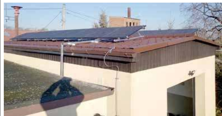
Na dachu remizy zamontowane zostały panele solarne (fot. Gm. Stepnica)
