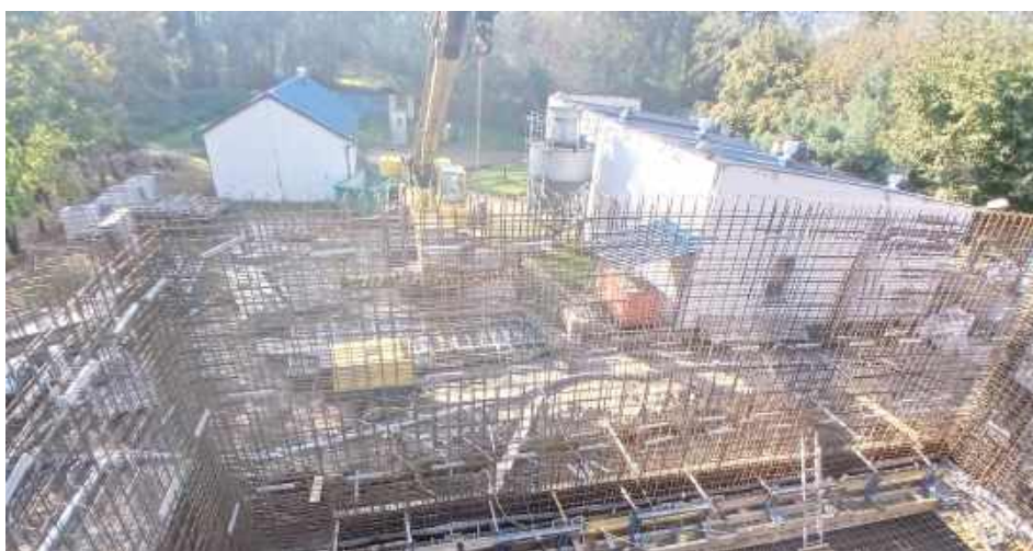
Wykonawcą robót przy oczyszczalni jest Zakład Elektrotechniczny ZELTECH z Siedlec. Wartość zadania wynosi 6 mln 981 tys. zł
