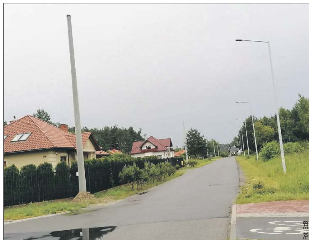
Betonowe słupy już są wkopane. Już czekają na założenie instalacji.
