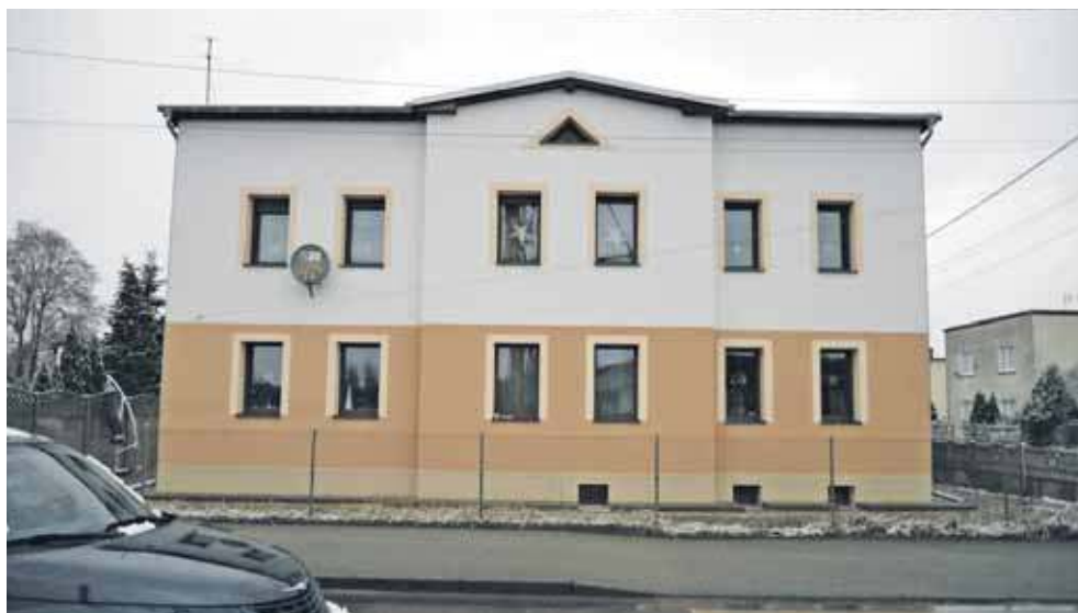
Budynek został poddany termomodernizacji za pieniądze z funduszy unijnych, którymi dysponuje Wojewódzki Fundusz Ochrony Środowiska i Gospodarki Wodnej w Katowicach
