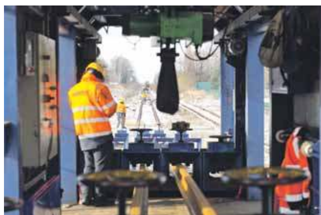
Prace na linii kolejowej 182 rozpoczęły się w Zawierciu
