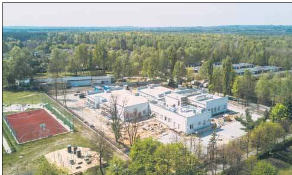
Przebudowa kosztowała około 10 mln zł
