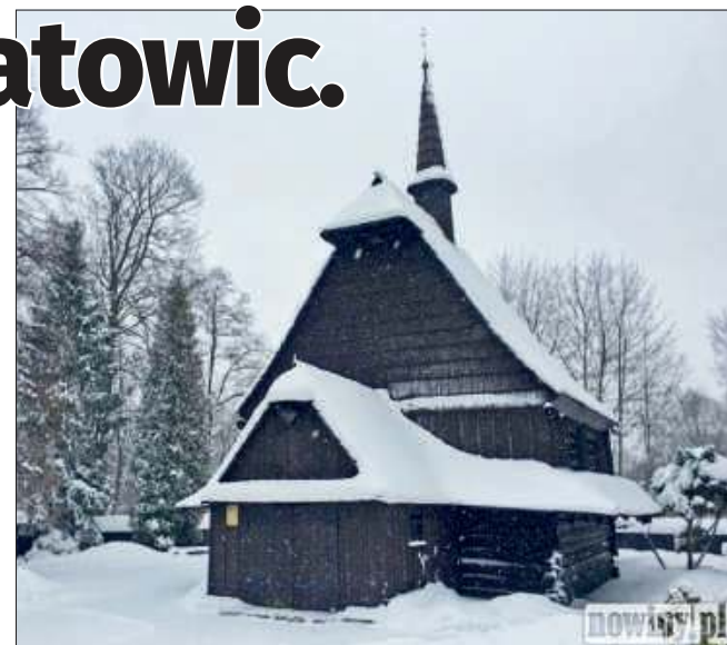
Uroda zabytkowej budowli oraz parkowych plenerów powoduje, że bardzo często odbywają się w nim śluby
