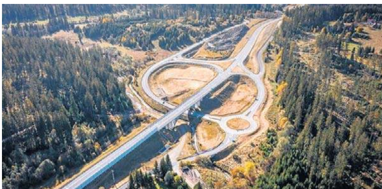
Most w Lalikach zostanie wyremontowany
