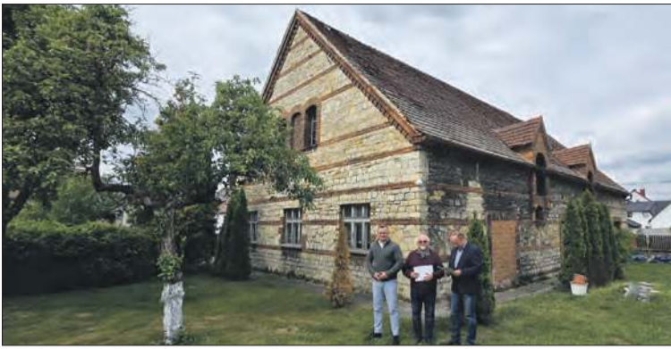
Remont obejmuje dach budynku
