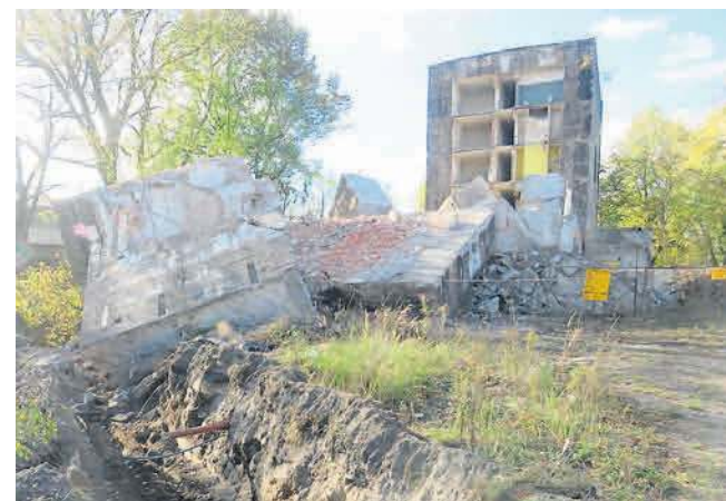
Ciekawostką jest to, że elewację takich schronów maskowano w ten sposób aby przypominały zwykły budynek mieszkalny
