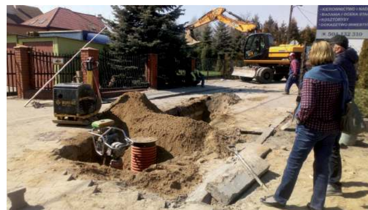
Budowa sieci kanalizacyjnej ul. Wiśniowa i Winogronowa
