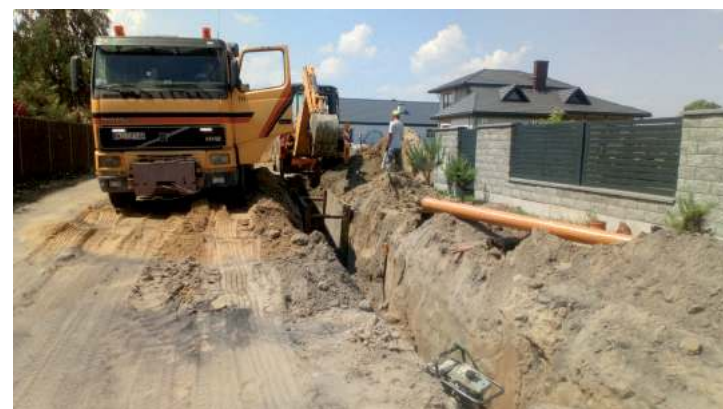
Budowa sieci kanalizacyjnej Osiedle Śniegockiego
