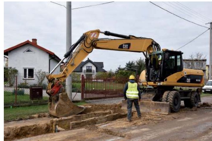
Budowa sieci kanalizacji ul. Białowiejska
