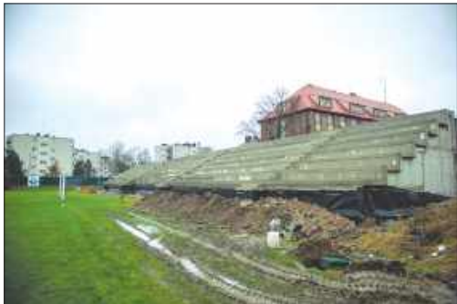
■ Przebudowa boiska Górnika Radlin (stan z początku grudnia)
