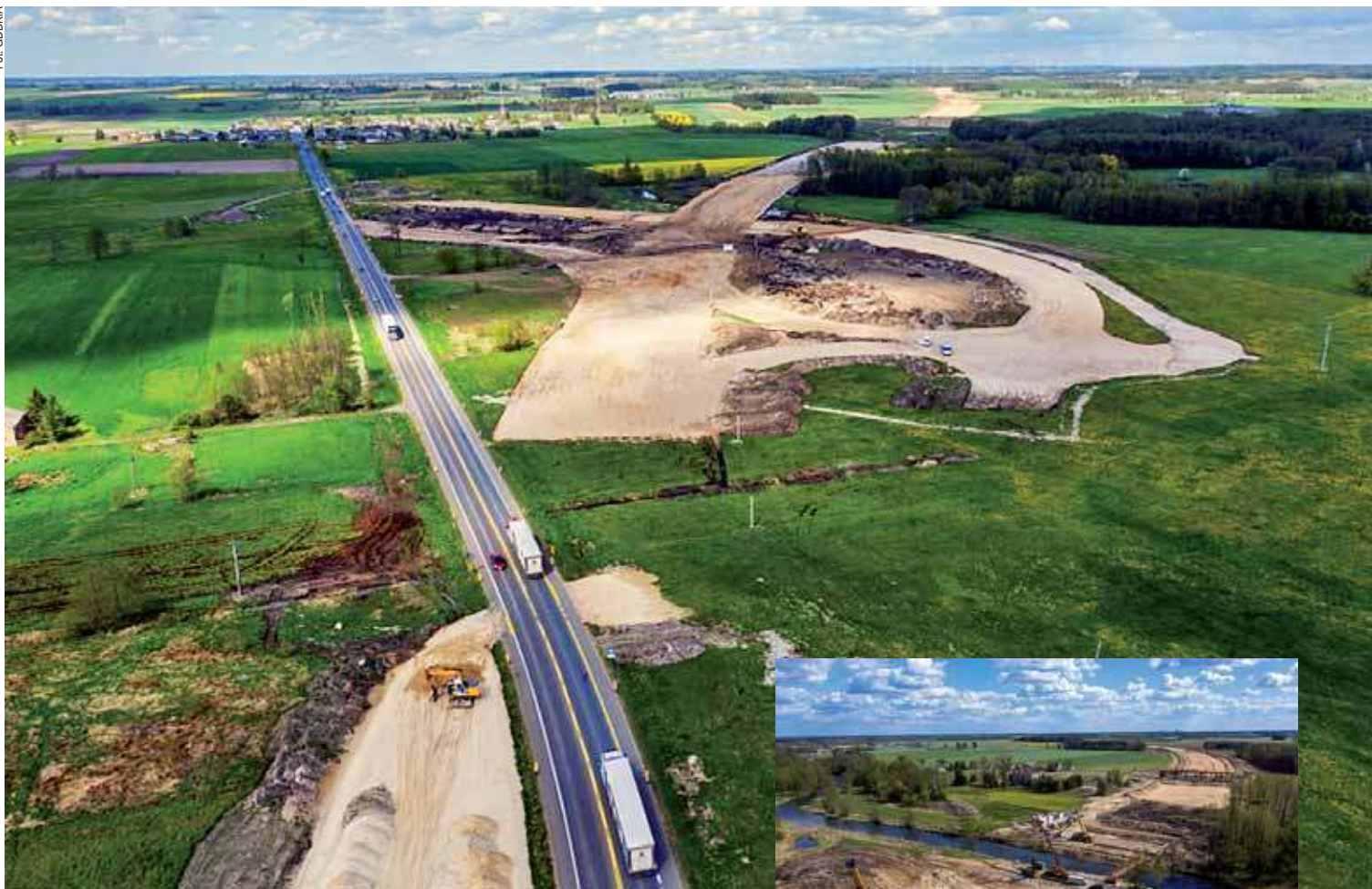
Inwestycja jest podzielona na cztery odcinki realizacyjne
