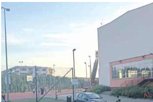
Strażacy zabezpieczyli zarówno rozszczeliony panel, jak i pozostałe. Dla bezpieczeństwa czasowo wyłączono obiekt z użytkowania
