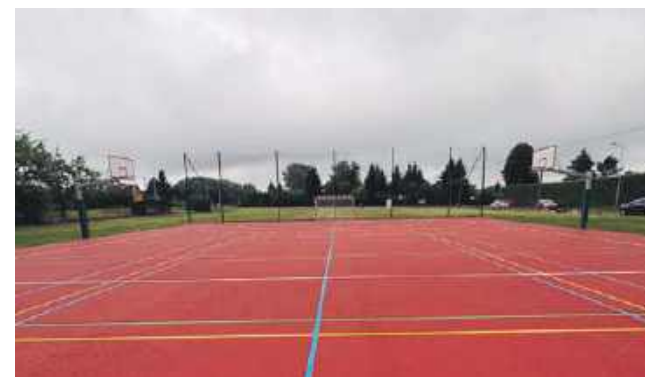
Nowe boisko wielofunkcyjne w Niekłonicach
