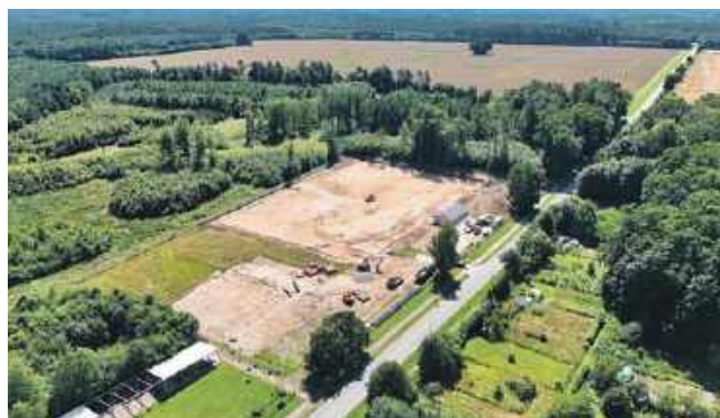
Budowa centrum turystyczno rekreacyjnego w Strzekęcinie
