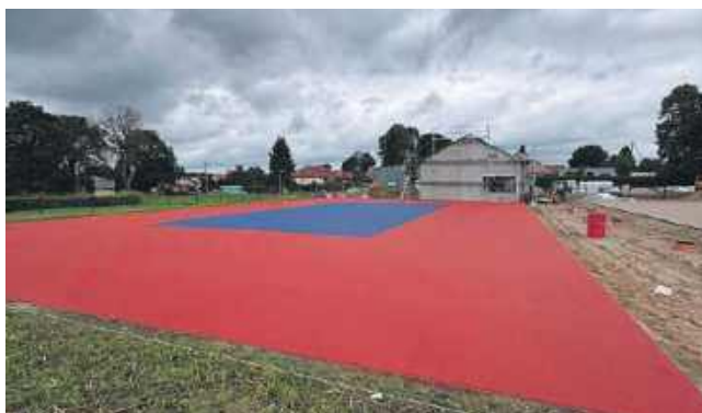
Budowa orlika w Konikowie
