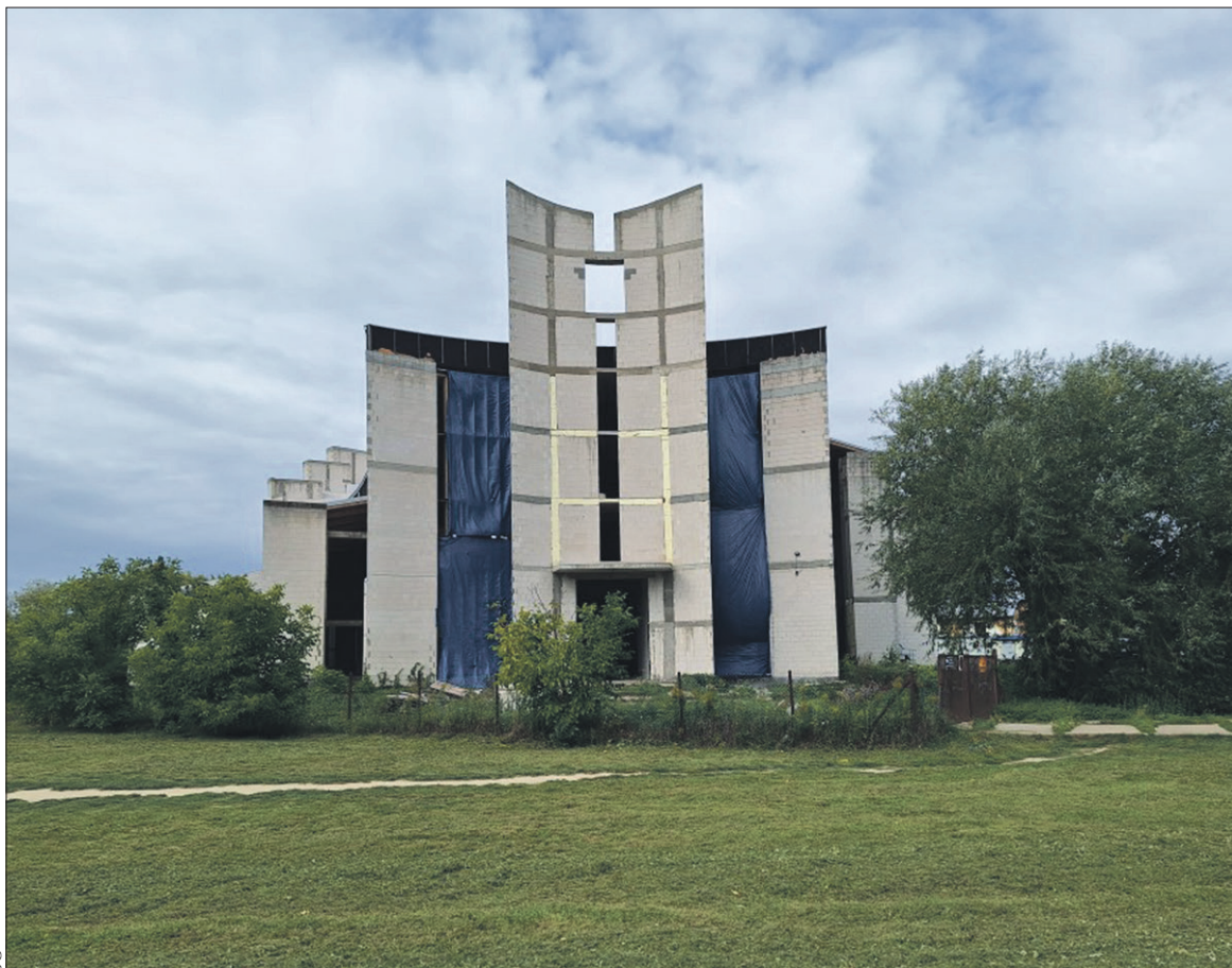
Będący w budowie kościół parafii św. Krzyża w Płocku
