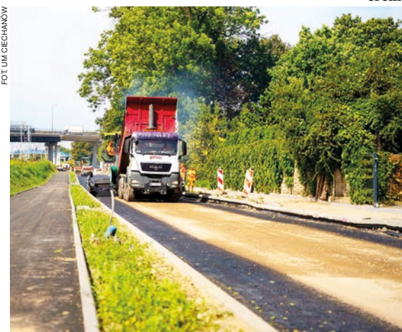
Prace na ulicy Fabrycznej
