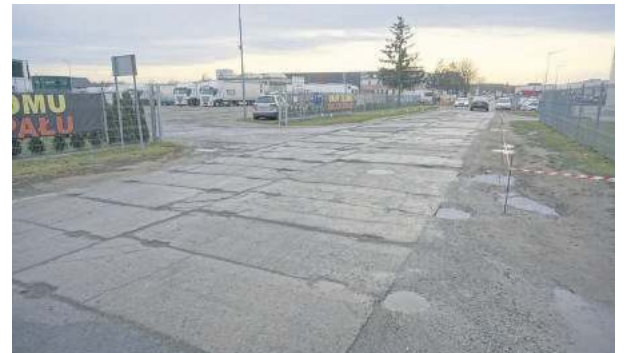
Remont ul. Energetyków będzie kosztować około 1,6 mln zł
