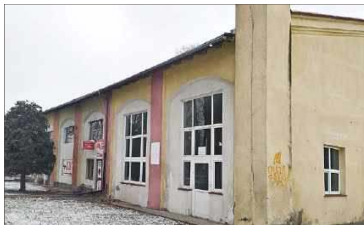
Hala przy Kościuszki była kiedyś konną ujeżdżalnią. To po ewentualnym remoncie chciałaby w formie murala przypomnieć dyrektor MOSiR.
