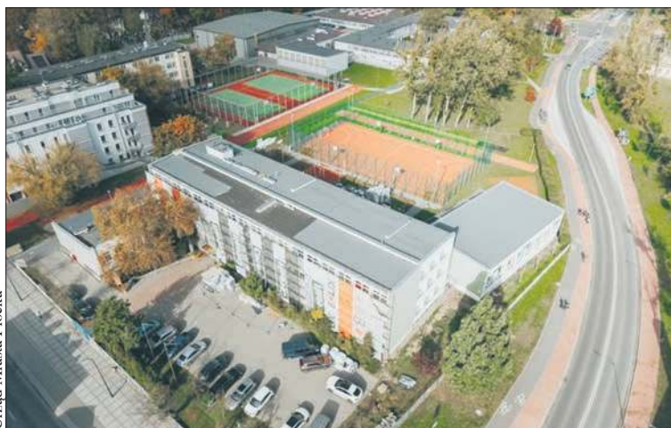
Dobiega końca termomodernizacja budynku płockiego „Ekonomika”
