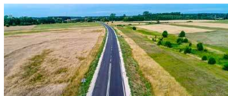
Modernizacja 28 km drogi powiatowej w powiecie węgrowskim to jedna z wielu inwestycji drogowych
