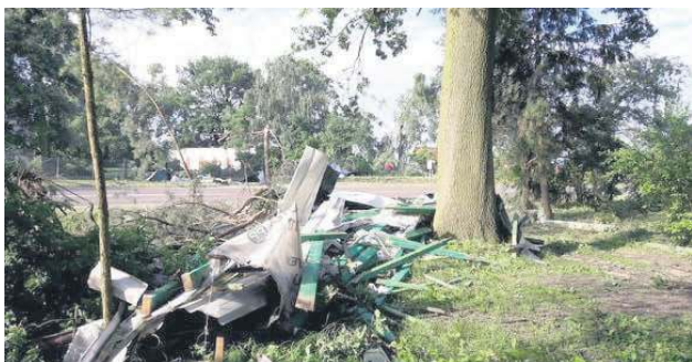
– W pewnym momencie nawałnica porywała całe dachy budynków. Jeden z nich przeleciał przez ulicę i zatrzymał się na ponad stuletnim dębie, który stoi przed moim domem. Wręcz owinał się wokół niego – opowiada Bartłomiej Sęczawa (on także jest autorem zdjęcia).
