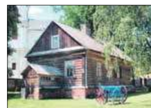
Dom Ksieni w Leśnej Podlaskiej powstał w XIX w. Budynek wykonany jest z drewna modrzewiowego i utrzymany w stylu architektury rosyjskiej jest pełen misternych detali
