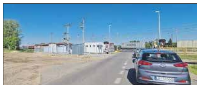
W tym miejscu powstanie wiadukt w ramach inwestycji związanej z budową Parku Logistycznego w Małaszewiczach
