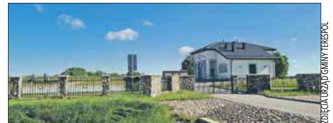
Wójt Krzysztof Iwaniuk zaznacza, że do ważnych inwestycji zalicza też zakończenie budowy cmentarza komunalnego w gminie. Na zdj. kaplica cmentarna
