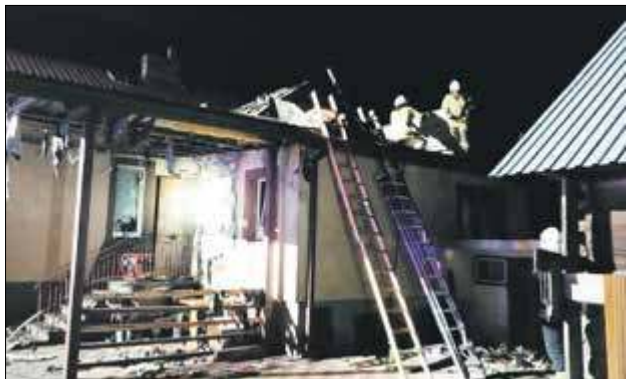
Koszty remontu częściowo spalonego budynku są ogromne, dlatego została zorganizowana zbiórka pieniędzy na ten cel
