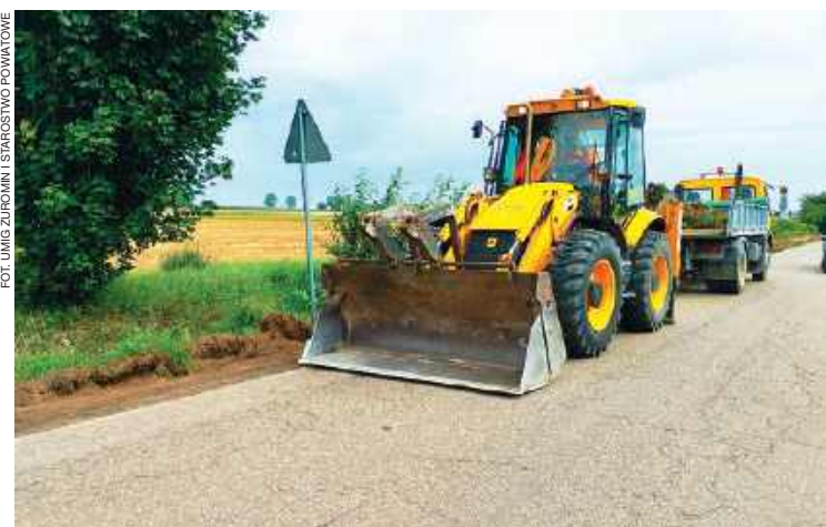
Sprzęt gotowy do robót na drodze powiatowej
