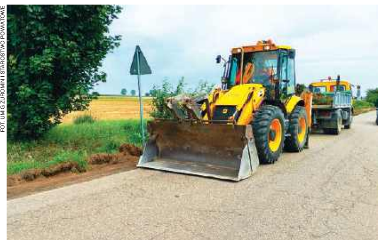
Sprzęt gotowy do robót na drodze powiatowej
