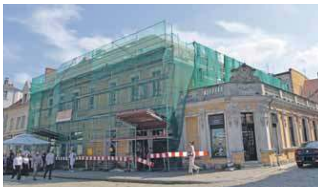
Dach ma być gotowy na przełomie września i października
