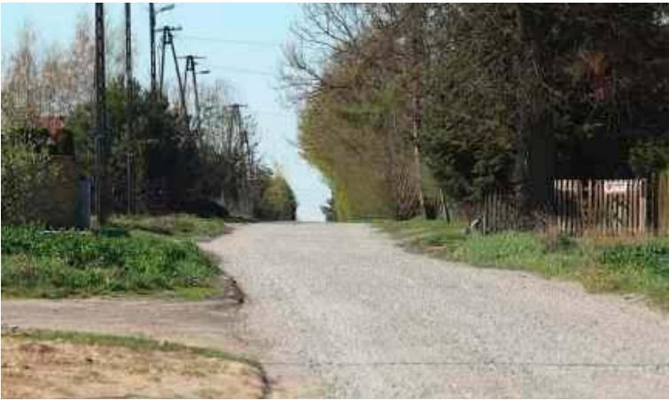
Na ulicy Drewnianej jeszcze w tym roku będzie asfalt, chodnik i kanalizacja
