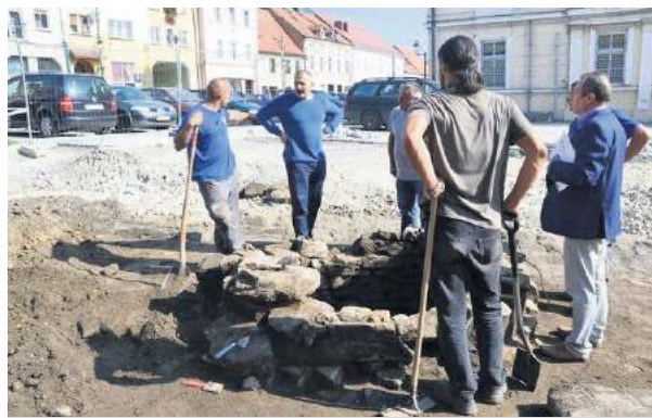
Niewątpliwą atrakcją rynku jest historyczna studnia. Tak wyglądały prace przy niej w ubiegłym roku. Drugi z lewej burmistrz Wiązowa Jerzy Krochmalny
