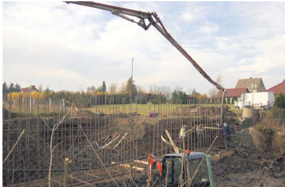
Pracownicy po wykonaniu zbrojenia przygotowują szalunek potrzebny do wylania betonu
