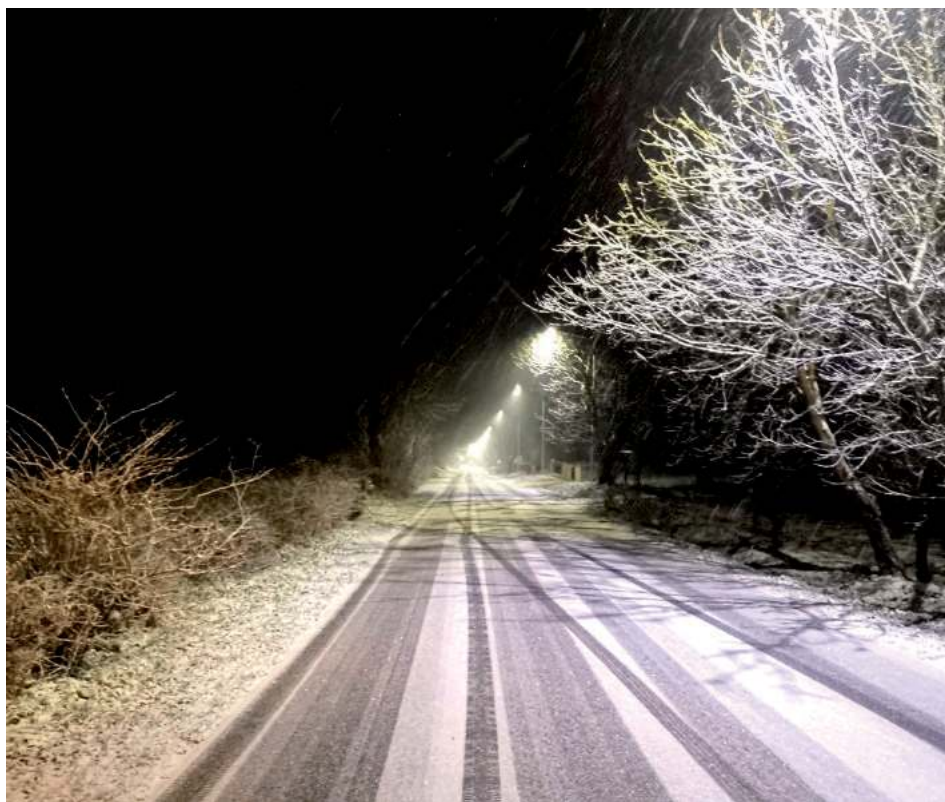
W Cholewiancie zamontowano kilkadziesiąt latarni
