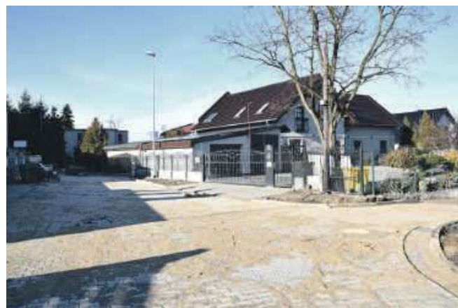
Budowa sięgacza ulicy Głównej w Psarach
