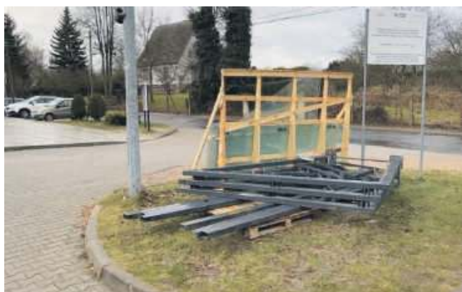
W sobotę rano elementy wiaty przywieziono pod trzebnicki basen
