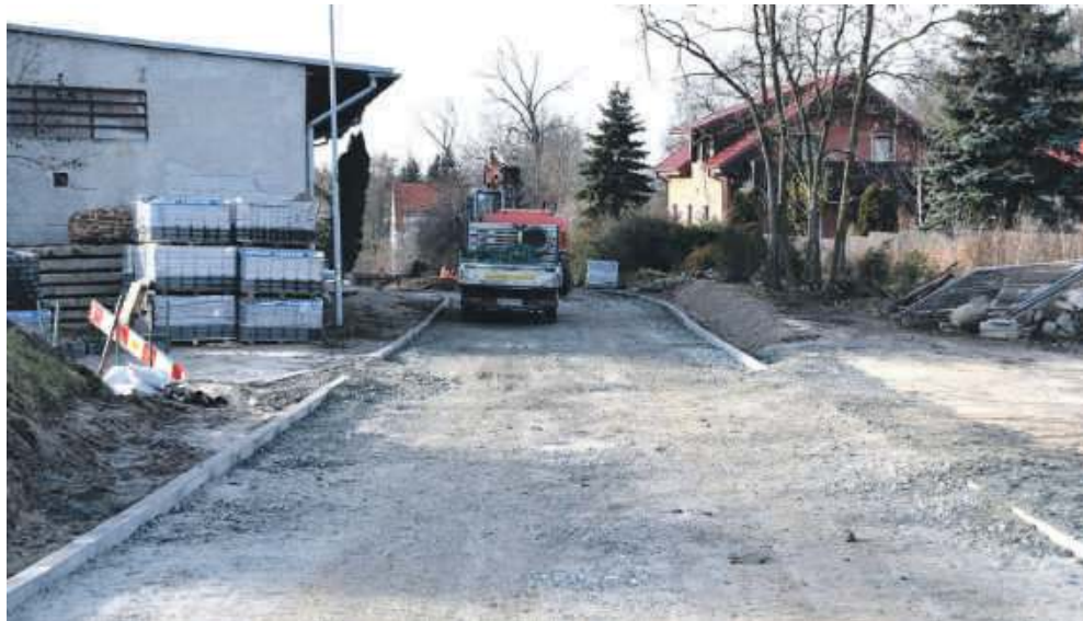
W Wiszni Małej rozpoczął się I etap przebudowy ulicy Polnej
