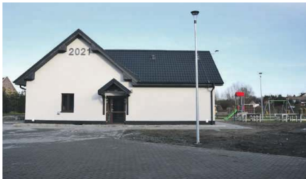
Na terenie przed nową świetlicą w Pierwoszowie dobiegają końca prace wykończeniowe
