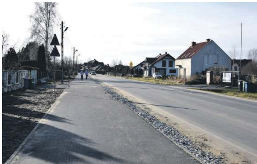
Na ulicy Długiej w Szewcach dobiega końca budowa I etapu ścieżki rowerowej
